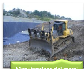
Manutenzione dei mezzi operativi in discarica
