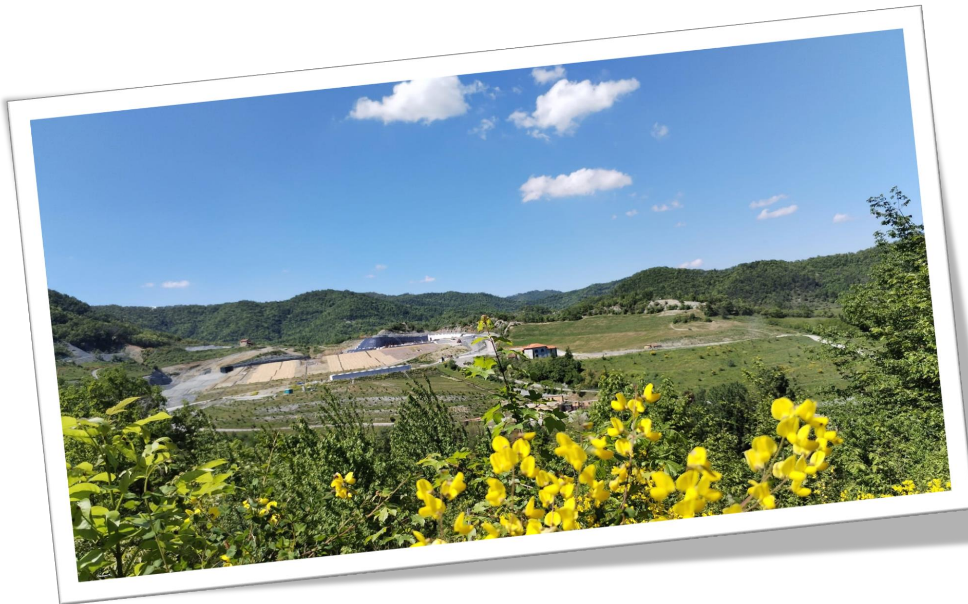
FOTO 1: Vista panoramica dell'area di discarica
