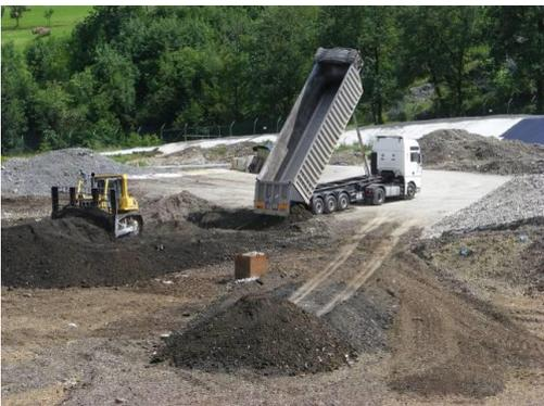
1. A seconda delle esigenze dell'operatore, invece che a ramblé si può procedere allo scarico in piano, facendo retromarcia verso una zona che si ritiene stabile e che l'autista approva.
