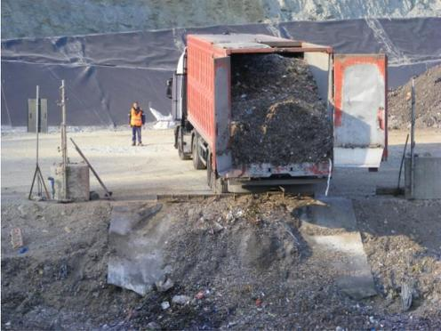
1. I mezzi si posizionano a ramblé con le ruote posteriori che vengono fermate su opportune piastre in ferro di fine corsa atte a segnalare per contrasto tra piastra e pneumatico il corretto posizionamento del veicolo sul punto di scarico ed evitare il cedimento accidentale del terreno.
