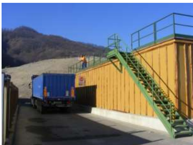
Varco di accesso e controllo
