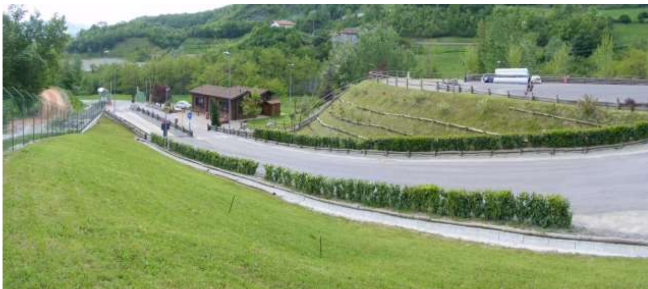
Viabilità Interna e Piazzale sosta
