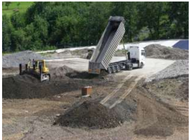
Scarico al piano deposito rifiuti
